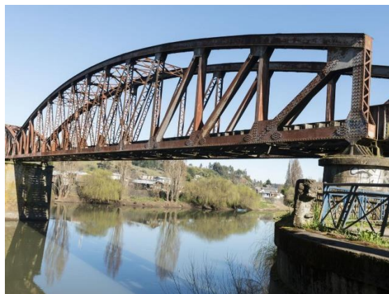
Puente Ferroviario sobre el río Chol Chol Fuente: Consejo de Monumentos Nacionales
