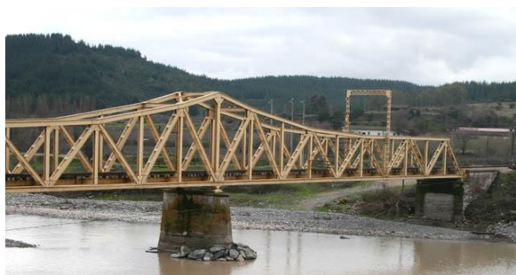
Puentes sobre el río Maule
