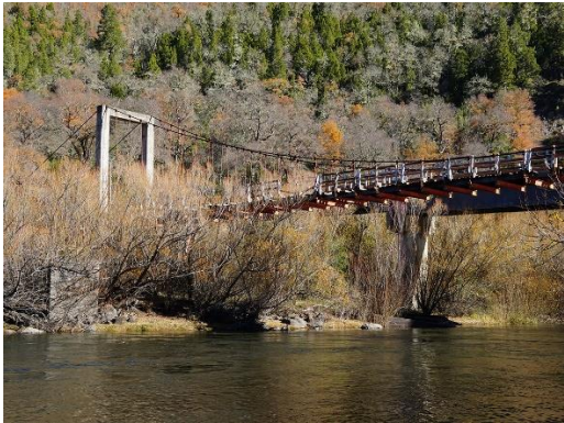
Puente Paso Paz
