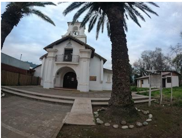
Iglesia Santa Begoña de Comalle
