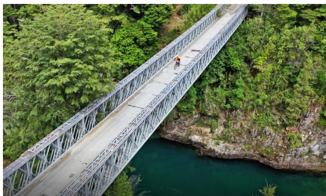
Puente La Dificultad
