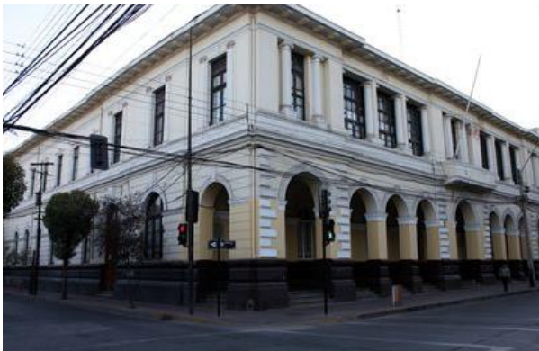
Edificio de la Gobernación
