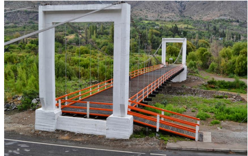
Figura N° 14 Puente Coirón Fuente: https://bit.ly/2ZwQU32
