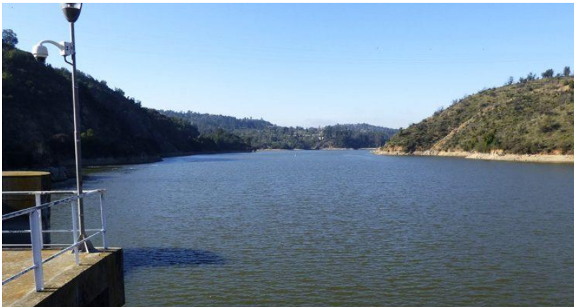
Figura N° 1 Central Hidroeléctrica Rapel
