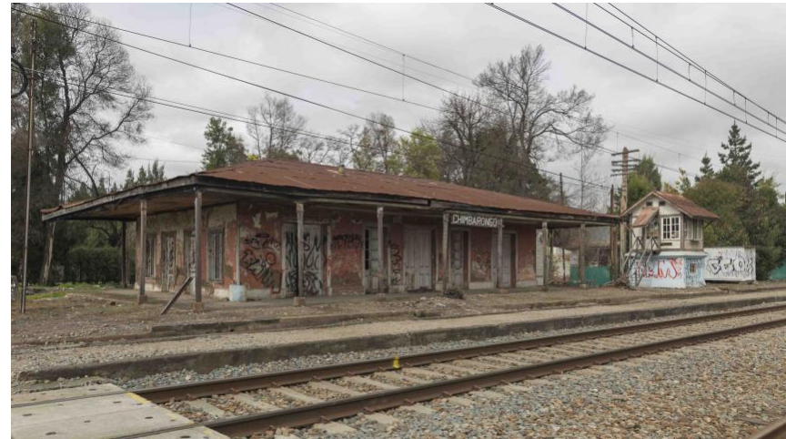
Figura N° 5 Estación de Ferrocarriles, Chimbarongo
